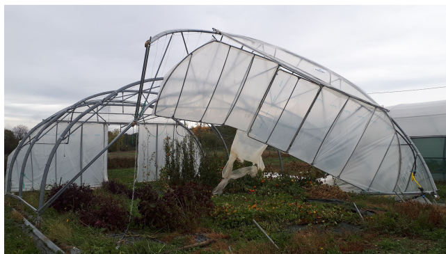
Figure 23: Les tunnel mobile après la tempête Barbara
